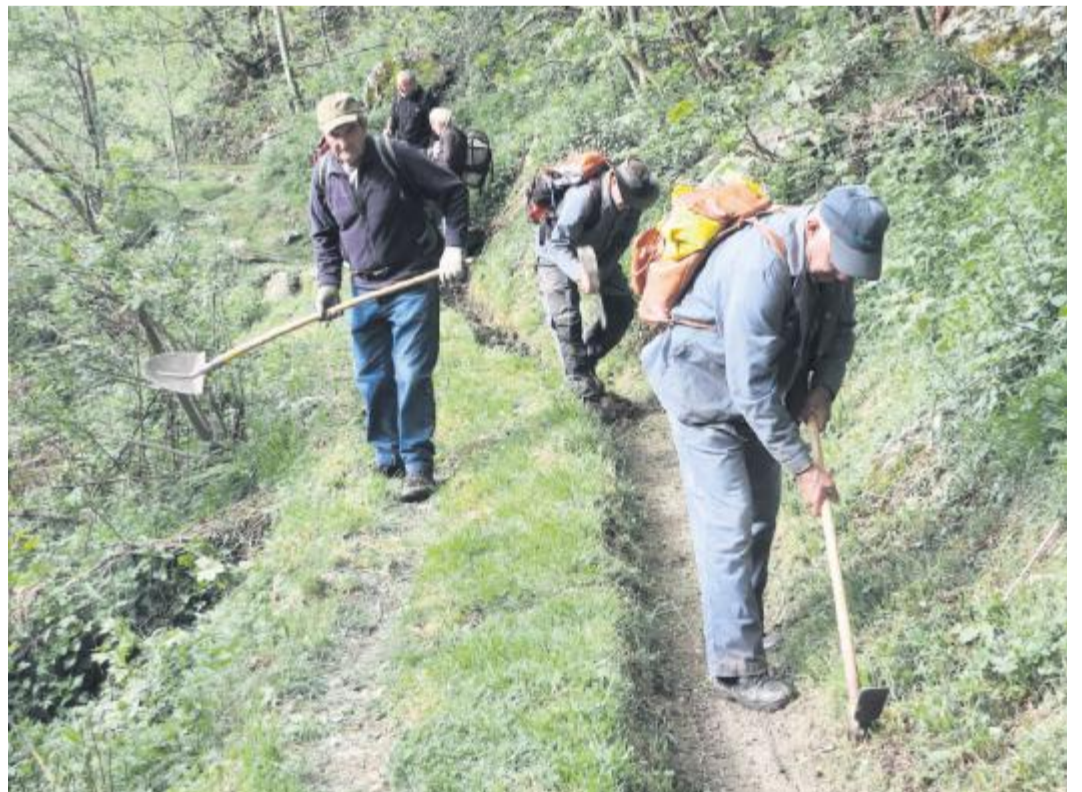
Am Werk. Die Wasserleitungen werden gereinigt, Steine, Äste und Laub entfernt.
