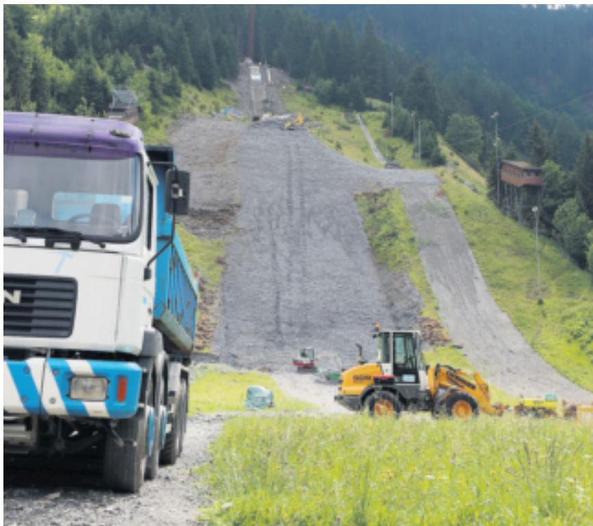
Auf dem NNSK-Gelände passiert etwas: Bald dürften die Profile der Anlaufspur montiert werden. Hell die Keramikspur für den Sommer, dunkel das Profil für die Eisanlaufspur.
