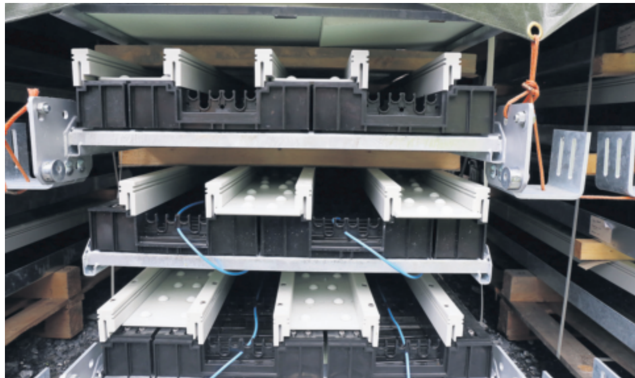
Auf dem NNSK-Gelände passiert etwas: Bald dürften die Profile der Anlaufspur montiert werden. Hell die Keramikspur für den Sommer, dunkel das Profil für die Eisanlaufspur.
