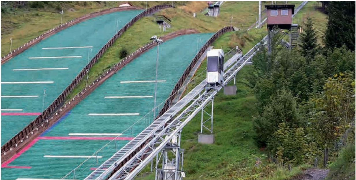
Die Schanzen und die Schienenbahn sind die neuen Vorzeigebjekte der Nordic Arena in Kandersteg im Berner Oberland.
