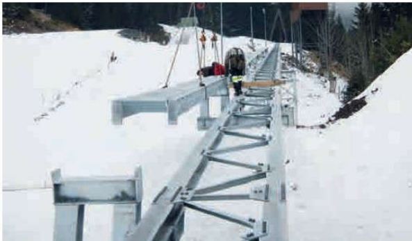
Die Bauarbeiter nutzten die eigene Materialseilbahn der ZURBRÜGG, um die Fundamente zu legen und die Fahrbahn zu montieren.
