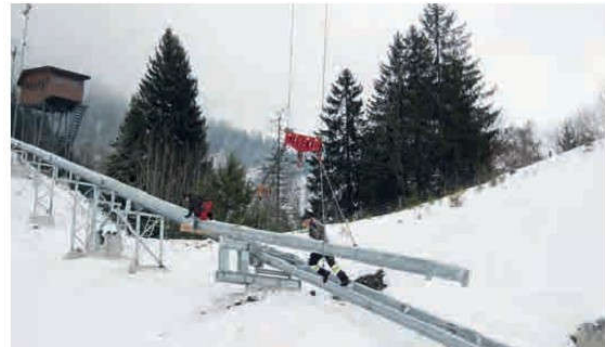
Die Bauarbeiter nutzten die eigene Materialseilbahn der ZURBRÜGG, um die Fundamente zu legen und die Fahrbahn zu montieren.
