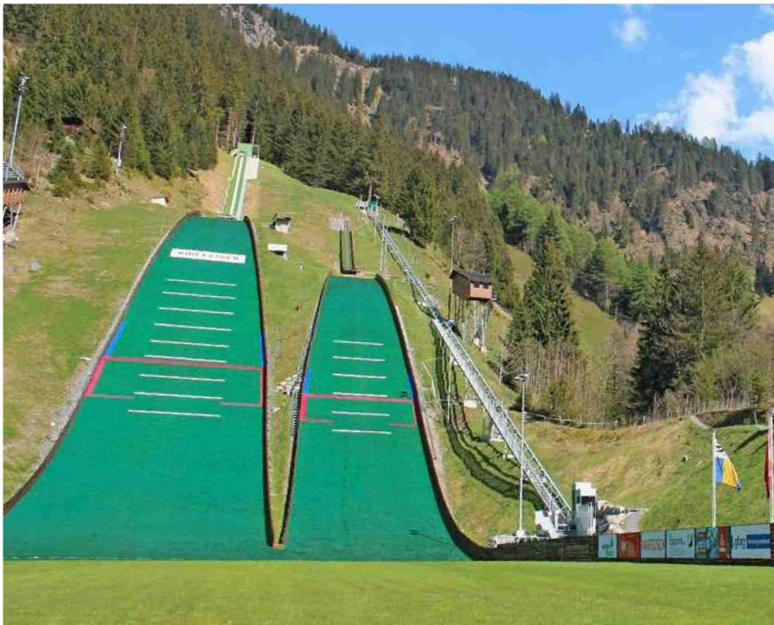
Blick in die Nordic Arena, wo die Anlaufspur der 70-Meter-Schanze (r.) zu ersetzen ist.
