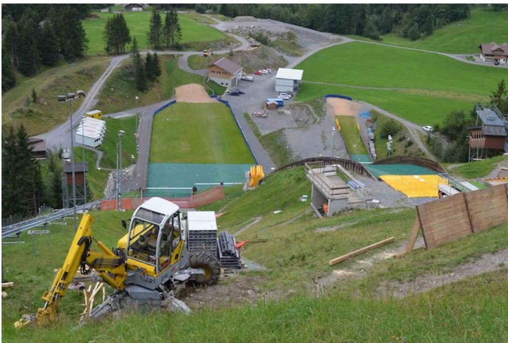
Während die Arbeiten an der Spur laufen, geht der normale Trainings- und Wettkampfbetrieb auf den restlichen Schanzen weiter. Fotos: Rabea Grand
